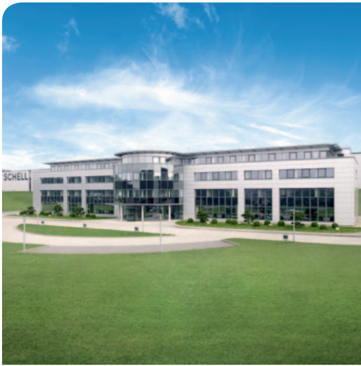
Werk 1 – Produktion mit Verwaltungsgebäude und Schulungszentrum
